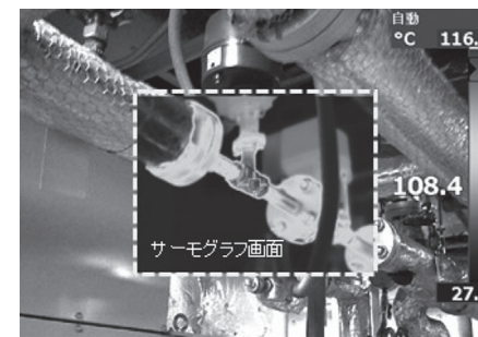
写真4 温水配管の保温をしていない箇所
