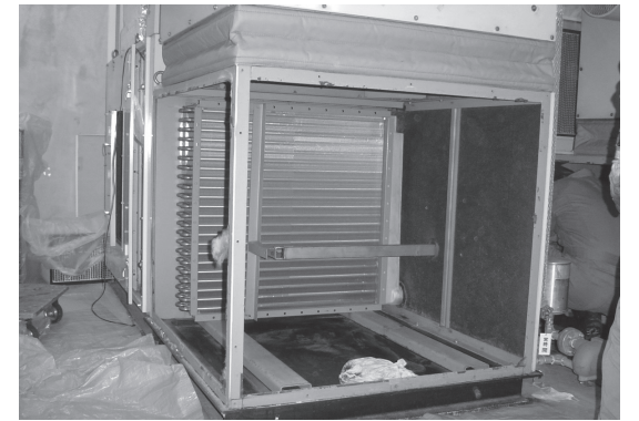
写真2 コイルの更新工事
