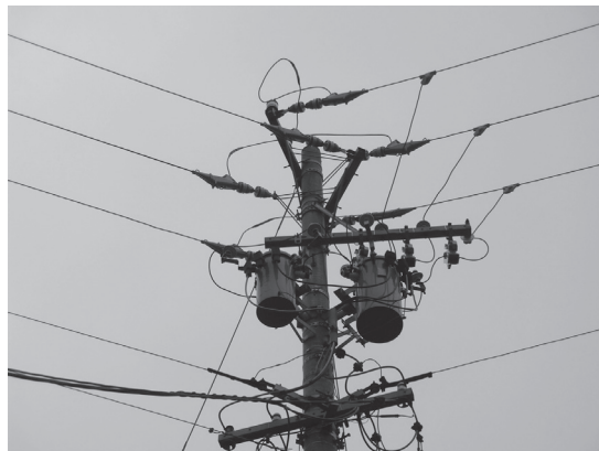
写真1 柱上変圧器の設置例
