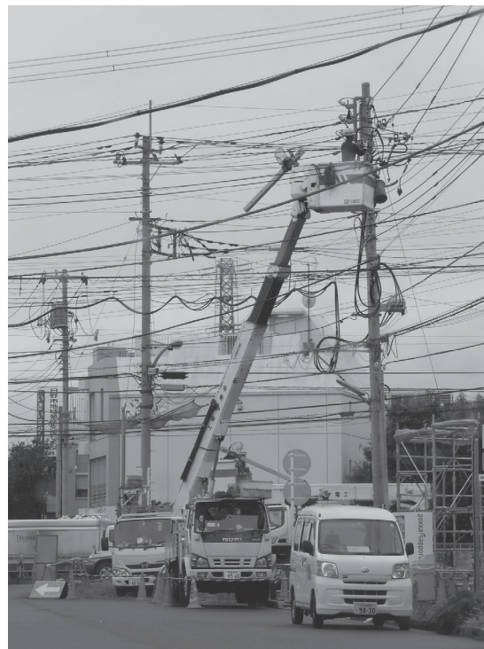
写真2 バケット車による高圧線工事例
