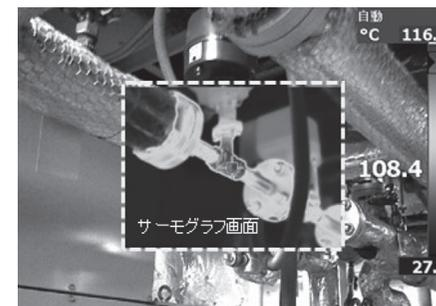
写真4 温水配管の保温をしていない箇所
