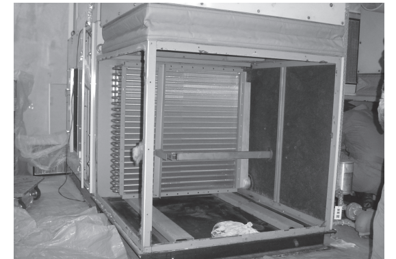
写真2 コイルの更新工事
