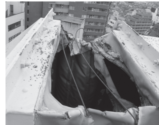
写真2 キャンバス継手上部の腐食穴あき
