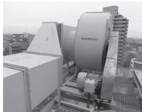
写真1 厨房排気ファンの設置状況
