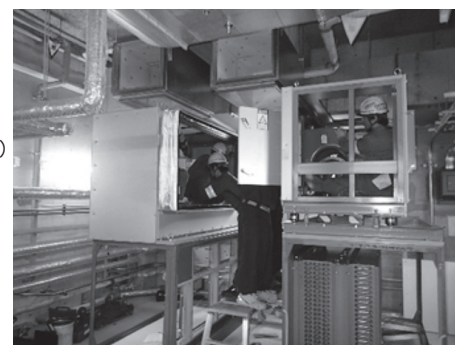
写真 全バラ空調機による更新作業の様子
