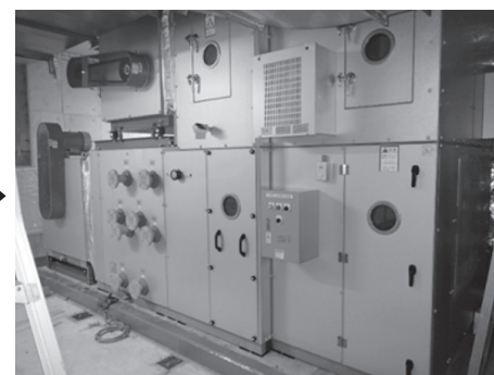
写真 全バラ空調機による更新作業の様子
