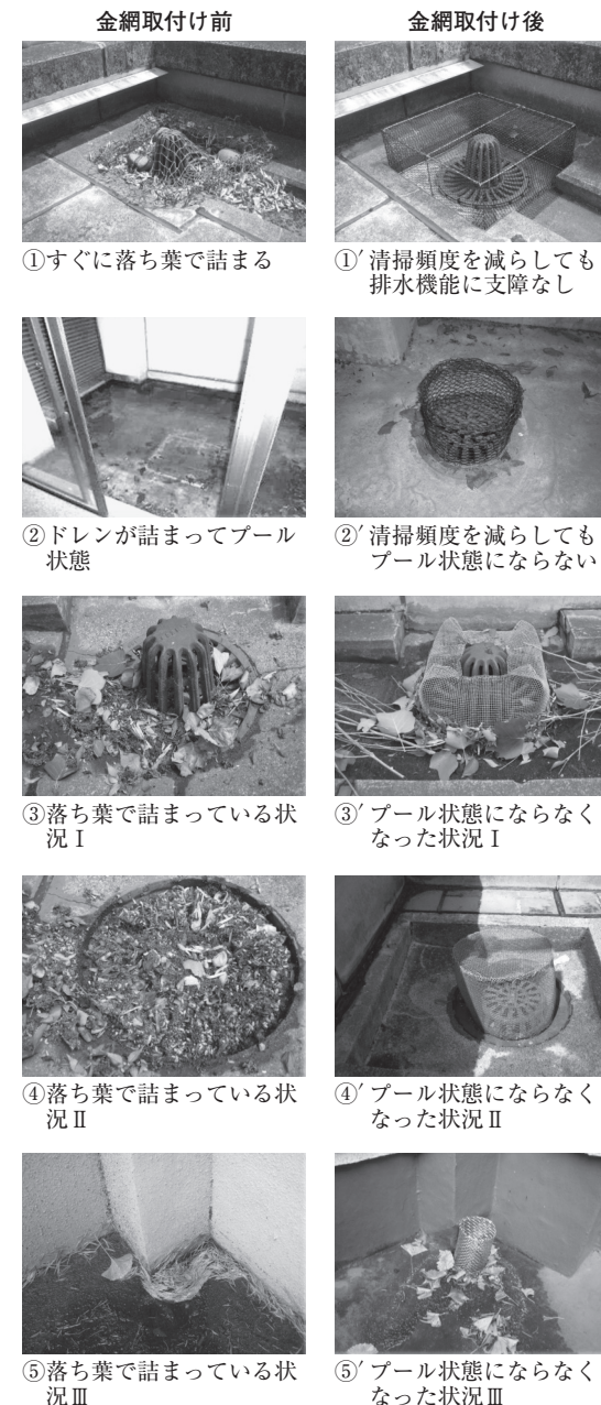
写真2 金網取り付け前と取り付け後の比較
