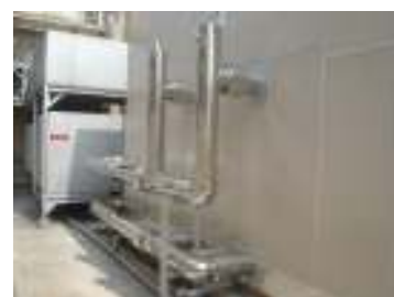
更新後の外周り配管(2系統)
