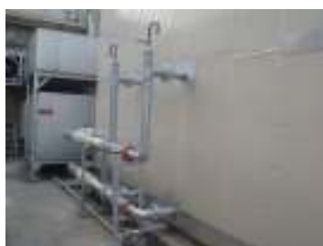
更新中の外周り配管(2系統)
