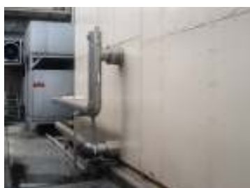
更新前の外周り配管
