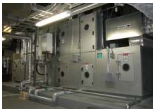
1. 2段ローター式置換換気空調機
