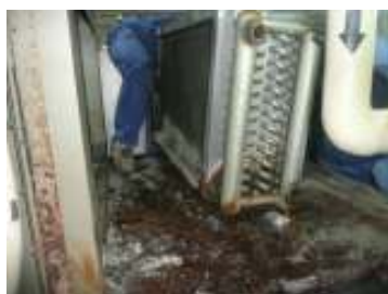
コイル下部補修前
