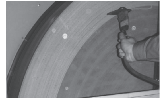
写真2 圧搾空気による塵埃除去状況
