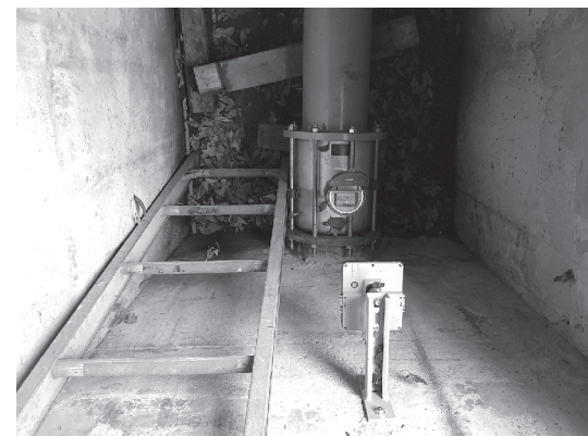
写真2 地下ピット内の給水メーター検針
