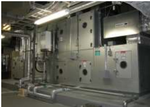
1. 2段ローター式置換換気空調機
