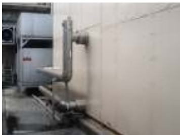
更新前の外周り配管
