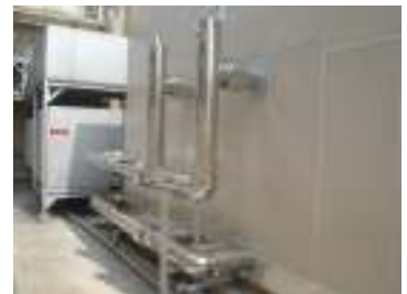
更新後の外周り配管(2系統)
