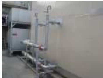
更新中の外周り配管(2系統)
