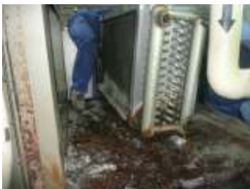
コイル下部補修前
